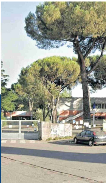
A sinistra l'Istituto Comprensivo Alberto Sordi in piazza Giuseppe Gola. Sopra l'Ic Giovanni Falcone in piazzale Hegel: il Tar ha bocciato l'accorpamento dei due istituti
